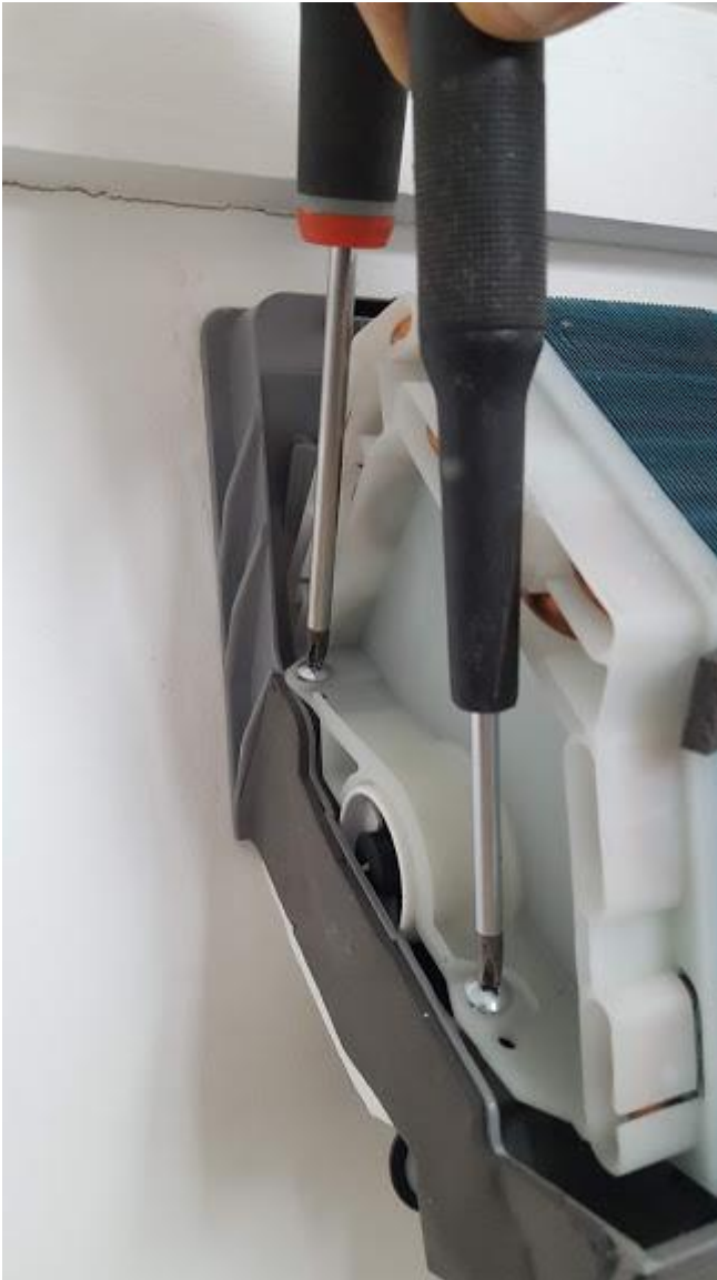
lossa plåthaken till elementet från kåpan till motorn
