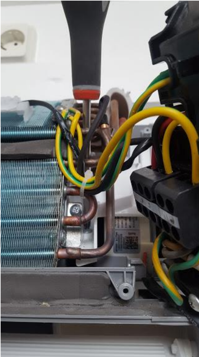
lossa skruven till elementet
