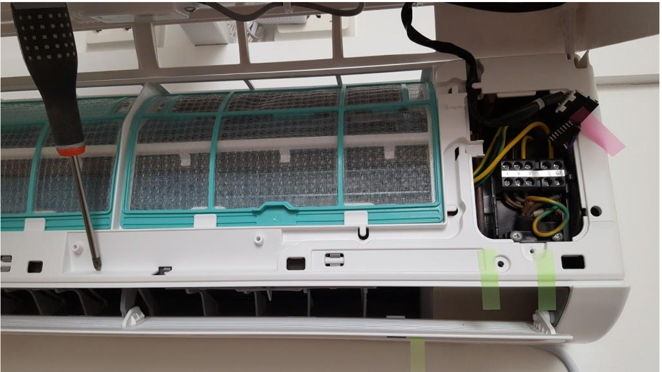
Dela fontens snäpp kopplingar med liten skruvmejsel
